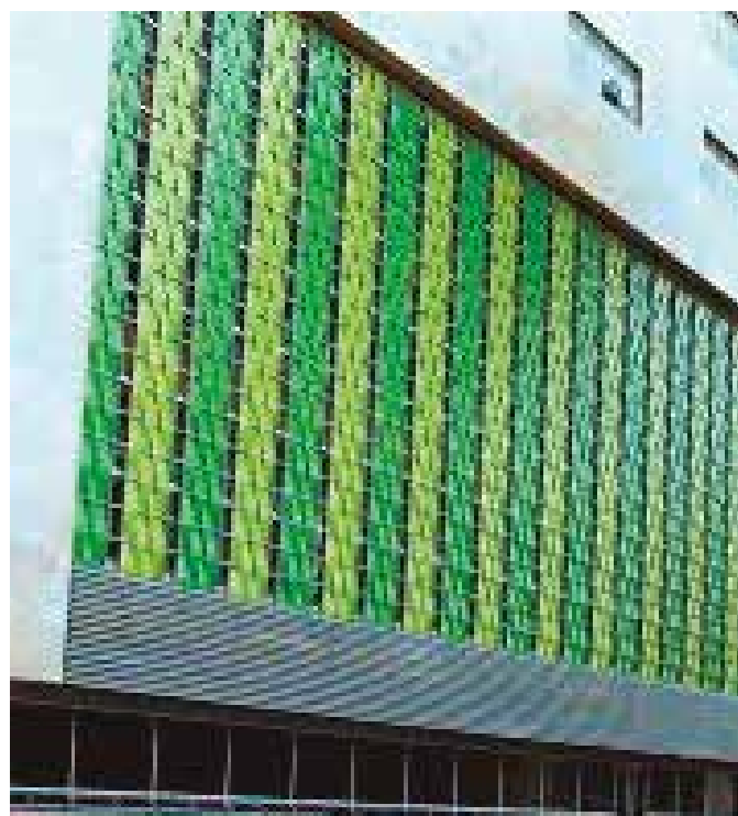
Edificio principal, Sede Bogotá
