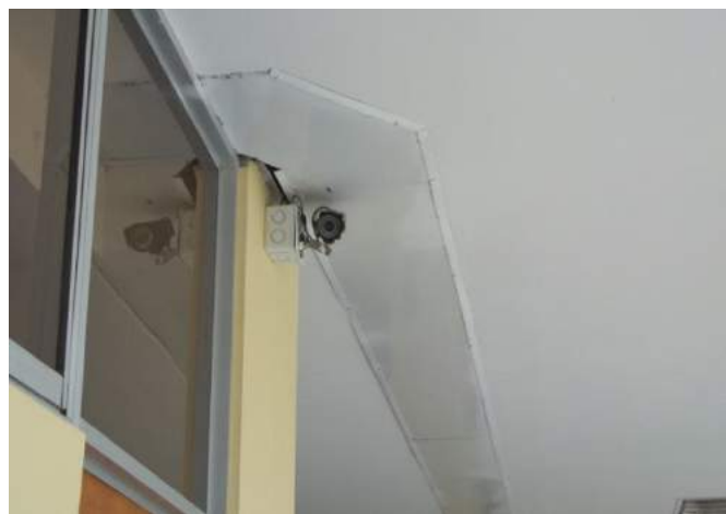
Foto 3. 8 Cámaras de Seguridad
